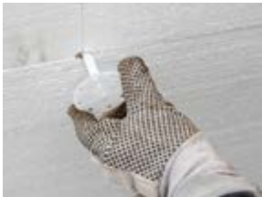
7. Дюбелирование: механически закрепите плиты тарельчатыми дюбелями. Количество дюбелей определяется расчетным методом.
