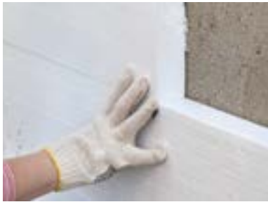
6. Шлифование: зашлифуйте все стыки плит, выровняйте поверхность.
