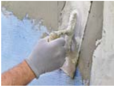
10. Армированный базовый слой: шпателем нанесите клей, утопите в него щелочестойкую стеклосетку и заглайте поверхность. Время выдержки не менее 72 часов.
