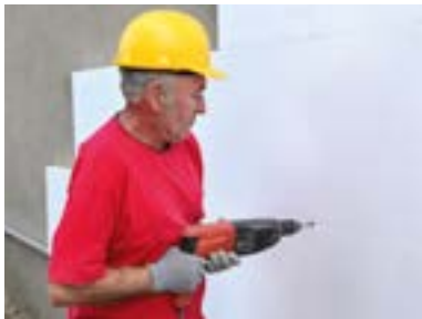
8. Дюбелирование: для крепления плит к пористым или деревянным основаниям используйте винтовые дюбели.
