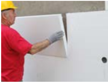
5. Монтаж плит: установите плиту в монтажное положение и плотно прижмите к основанию. Время выдержки не менее 3 суток.
