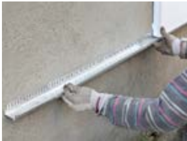
3. Цокольные профили: выставить по уровню, закрепить анкерными дюбелями, выровнять с помощью прокладок и соединительных элементов.
