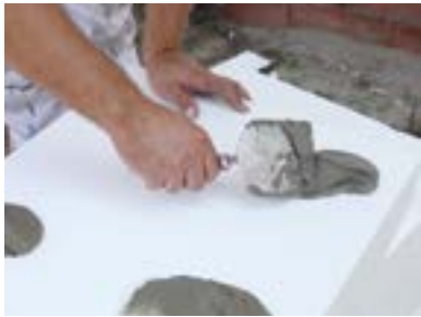
4. Нанесение клея: нанесите клей на плиту периметрально-точечным методом. Площадь клеевого контакта должна составлять не менее 40%
